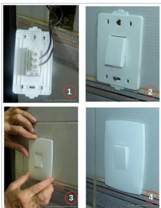
Figura 72 - Instalando o novo interruptor.
