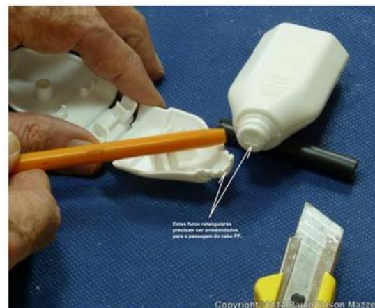
Figura 26 - Os furos retangulares do plugue e da tomada, por onde entram os cabos PP, precisam ser arredondados para a passagem do cabo PP. Faça isso com uma lima redonda, canivete ou estilete de corte. No caso de usar os dois últimos, muito cuidado para não machucar os dedos.
