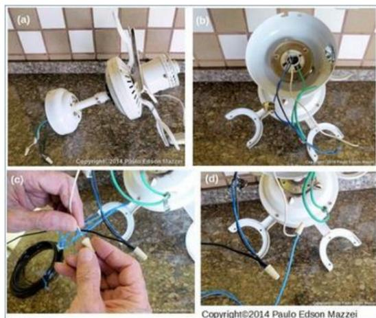
**Figura 107 - Instalação elétrica de um ventilador de teto.**
