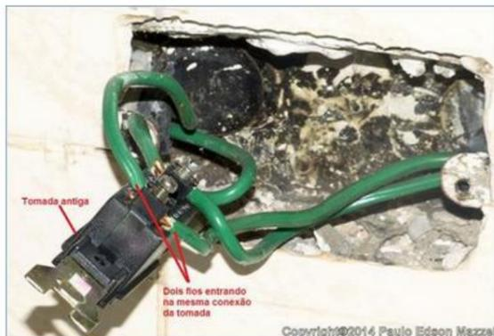
Figura 60 - Tomada antiga com fios rígidos. Cada conexão da tomada tem dois fios, pois desta caixinha vai também para outras caixinhas de tomada.
