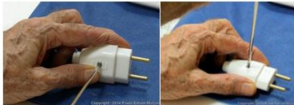
Figura 23 - Solte o parafuso para abrir o plugue. Cuidado que a chave de fenda pode escapar e causar acidentes.
