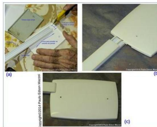
**Figura 100 - Corte na tampa cega para encaixar a canaleta.**
