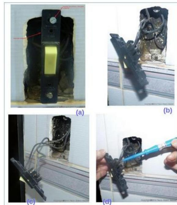
Figura 69 - Sequencia de retirada e teste da tomada antiga.
