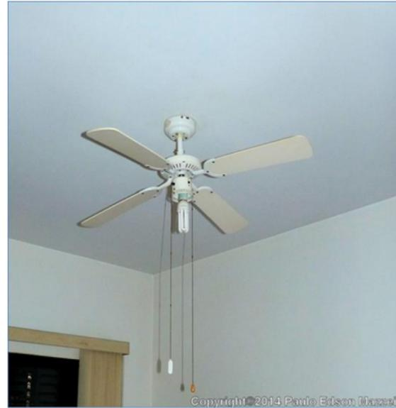
**Figura 108 - Ventilador montado, preso ao teto. O globo de vidro não encaixava devido ao tamanho da lâmpada compacta.**
