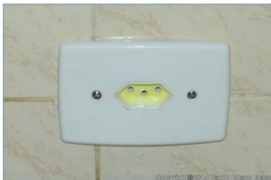
Figura 63 - Tomada pronta e instalada corretamente na parede. Belo trabalho, hein...??
