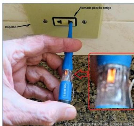
Figura 55 - Teste de uma tomada antiga que está funcionando normal.
