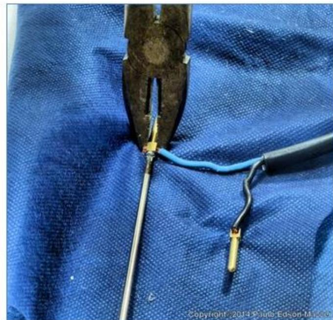
**Figura 35 - Segurando o pino do plugue para apertar o parafuso que prende o cabo.**
